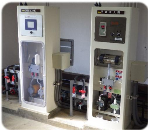
図 5-1.次亜塩素酸ナトリウム注入設備
