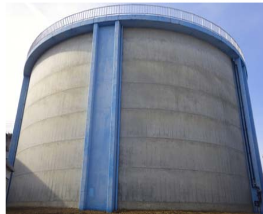
幸田配水場 配水池
