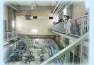
小金浄水場: 配水ポンプ室
