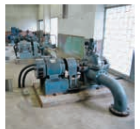
幸田配水場 配水ポンプ
