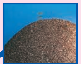
更新中のろ過機の内部
