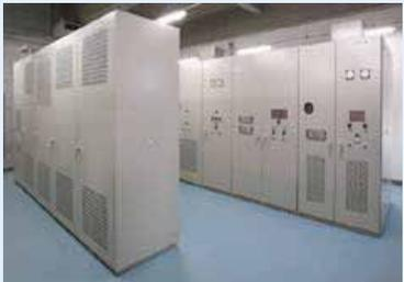
配水ポンプなど、各種機械の動力源・計装・制御機器などの電源設備を設置しています。
