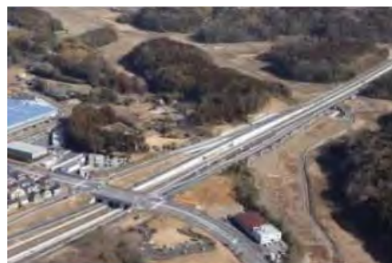
写真2：印西市若萩付近（平成31年2月）
