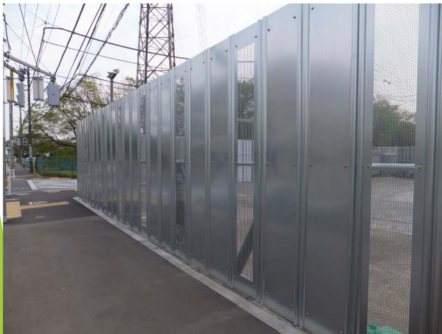
粉塵・騒音対策の例(仮囲い)
