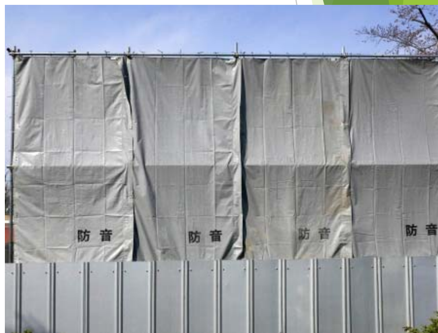
騒音対策の例(防音シート)
