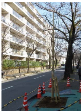
サクラ植栽工事
