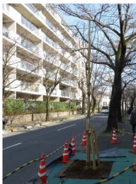
サクラ植栽工事
