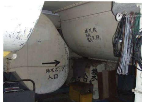
図 4-2-12 老朽化する空調関連設備
