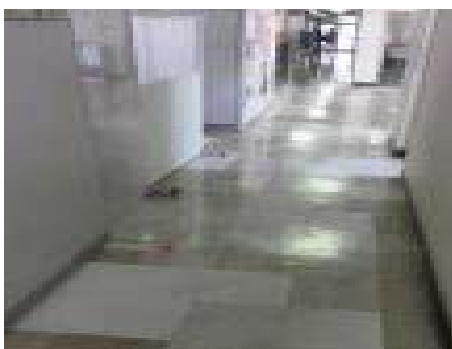
図 4-2-17 狭あいな通路
