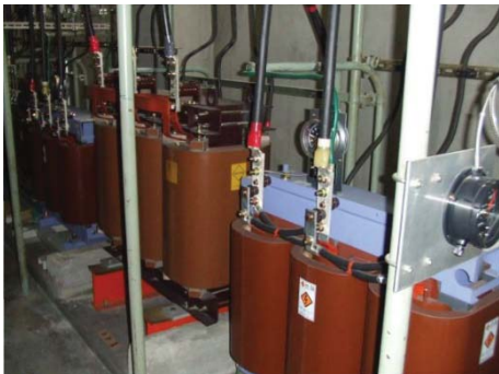
図 4-2-13 旧式電気設備
