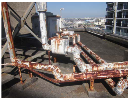
図 4-2-7 錆びついた給水管
