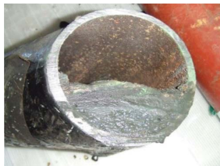
図 4-2-8 堆積物による排水管詰まり
