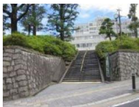
図 4-2-18 階段を使用して庁舎へ
