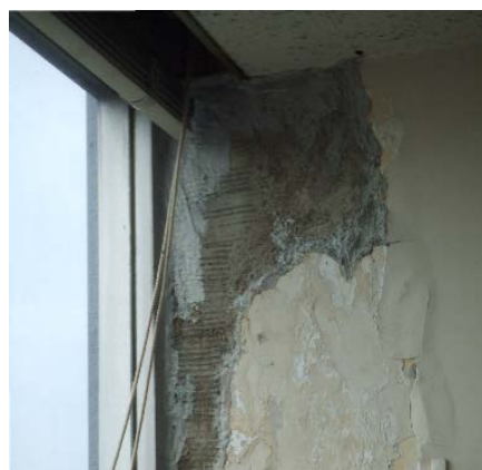
図 4-2-6 内壁の損傷
