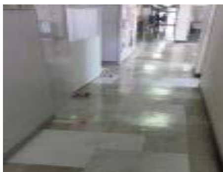
図 4-2-17 狭あいな通路
