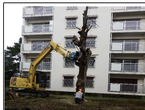
オ 樹木伐採施工状況
