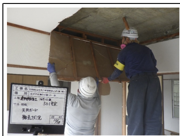
エ 内装解体施工状況
