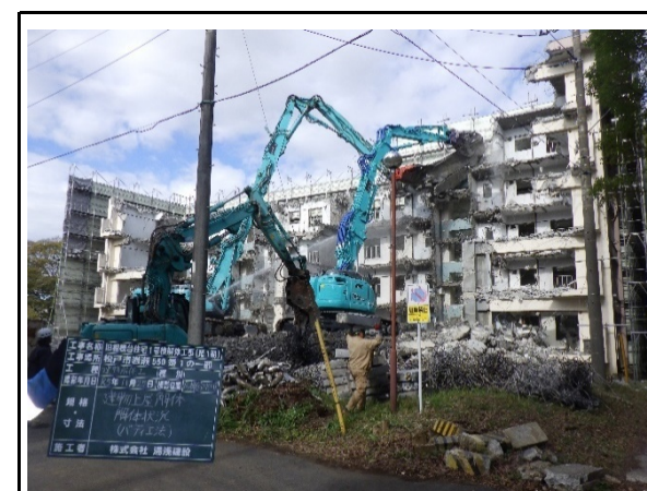
カ 建物解体施工状況
