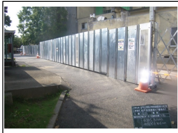
イ 仮囲い：万能鋼板H=2.0m
