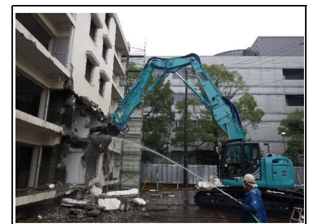
キ 解体作業時散水状況
