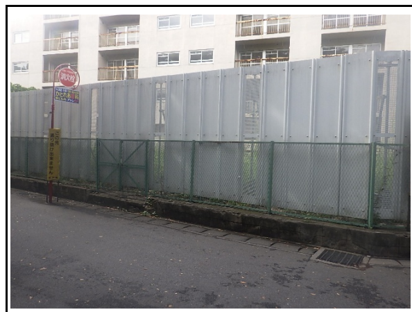
ウ 仮囲い：万能鋼板H=3.0m
