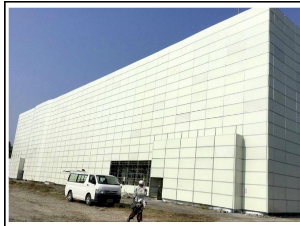
ア 外部足場（防音パネ張り）
