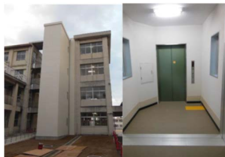
◎令和2年5月にバリアフリー法の改正により バリアフリー化が努力義務化。(長寿命化改 修工事とは別にエレベーター設置工事を進め ます。)
