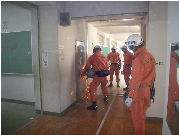
既存の建物を破壊し進入、負傷者の元へ②
