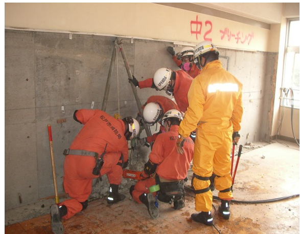
既存の建物を破壊し進入、負傷者の元へ③
