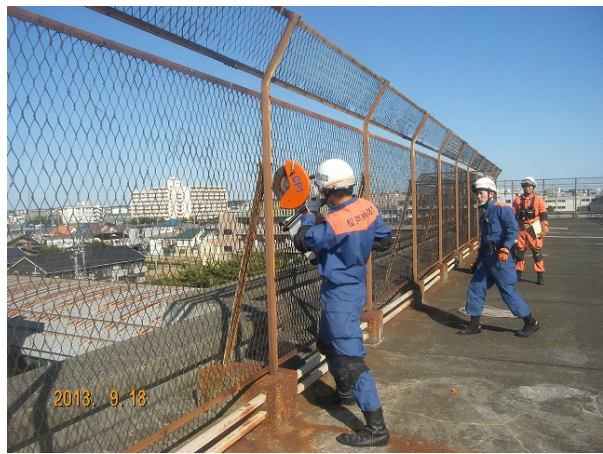
既存の建物を破壊し進入、負傷者の元へ①
