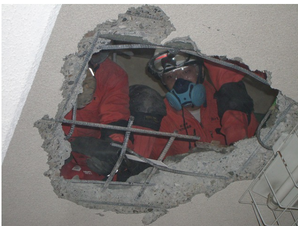
迷路状態の建物内を捜索し、負傷者発見・救出活動①
