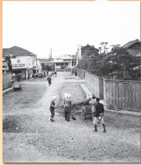
松戸駅東口駅前道路 (1955(昭和30)年)
