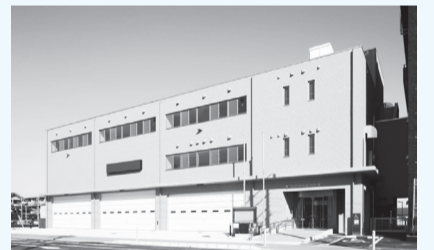
中央消防署新庁舎
