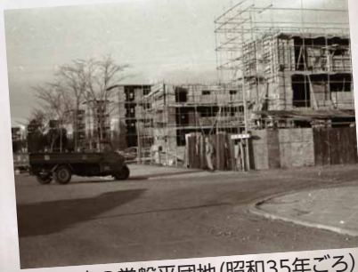
建設中の常盤平団地 (昭和35年ごろ)
