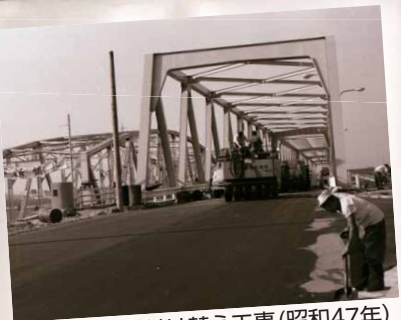
葛飾橋付け替え工事 (昭和47年)
