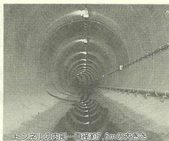
トンネルの内部、直径7.6mの大きさ
