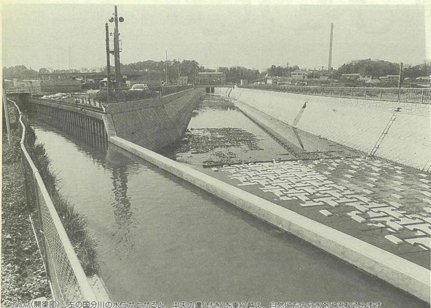
分派点(開渠部) 左の国分川の水位が上がると、中央の堰(せき)を乗り越え、自然に右の分水路に流れ込みます
