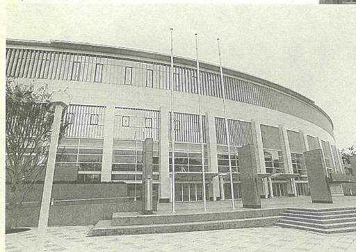
**大ホール...**森のホール21の顔である大ホールの客席は1,955席。シェーボックス型の構造(ホールの空間が箱型)と、ジュルター式の走行式音響反射板の導入により、音楽専用ホールに匹敵する音響性能を持っています。
