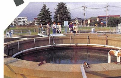
(分水井)水質の調整をし、四つある沈でん池へバランスよく水を配分します。
