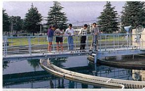
(沈でん池)にごりを薬品で固めて取り除きます
