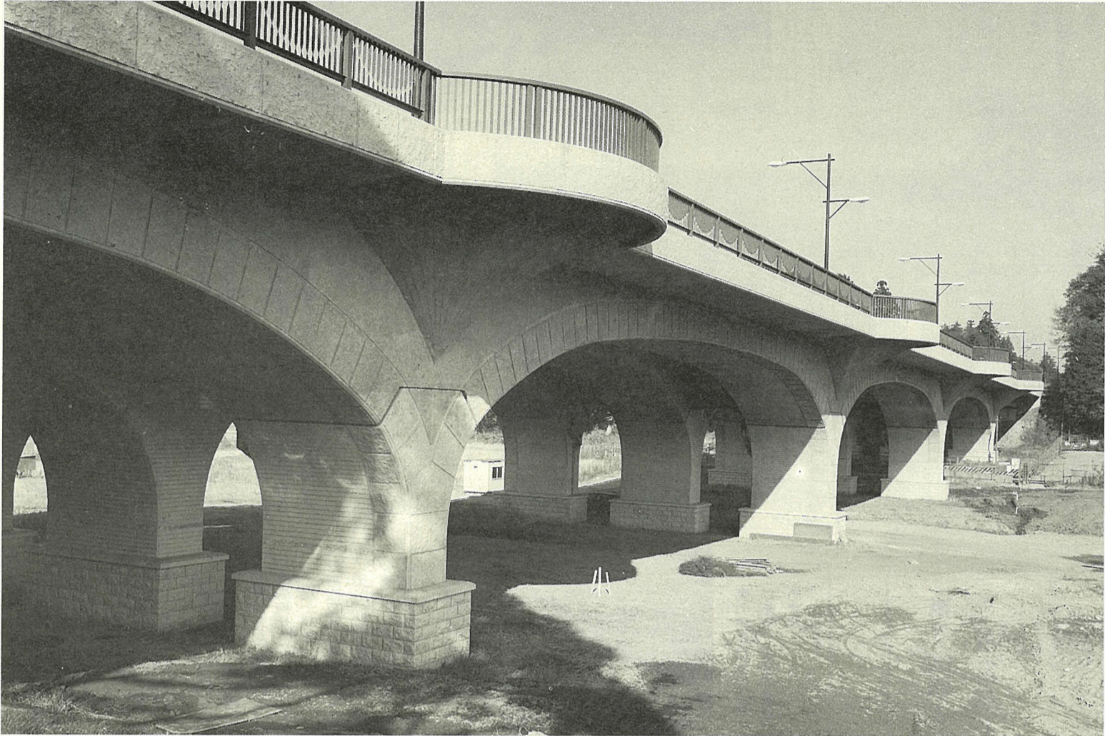
曲線の美しい2号橋
