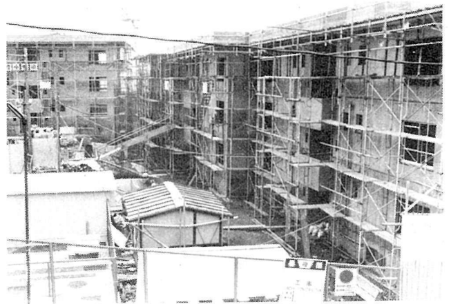
昭和57年 着々と整備される市営住宅（写真は天神山第2市営住宅の建設風景）
