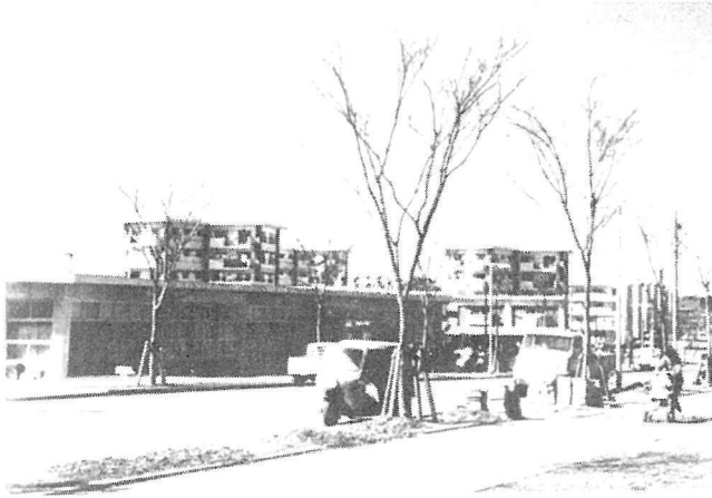
昭和36年 常盤平支所付近から見た常盤平団地
