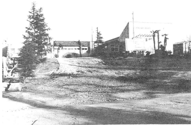
昭和37年 現在の第二中学校付近にあった旧松戸市立国保病院
