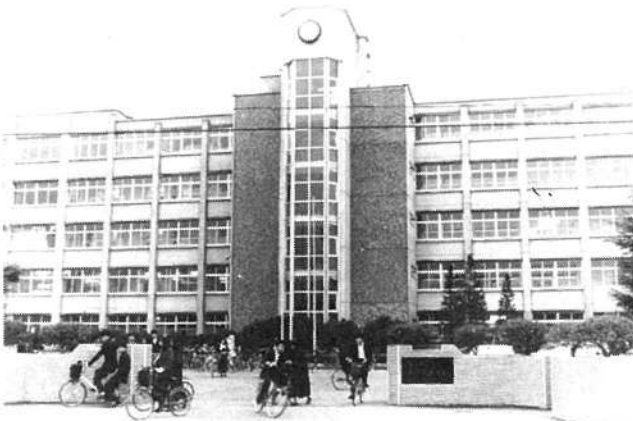
昭和51年 牧野原小学校内の仮校舎でスタートした市立高校の校舎が完成
