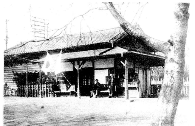
昭和初期 北小金停車場(駅舎)
