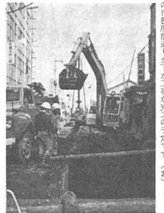
昨年度に引き続き、今年度も都市下水道工事が総工費約一億円で進められており、台風シーズンまでに松戸駅東口の市役所前通り全下水道工事が完工の予定です。(左)
