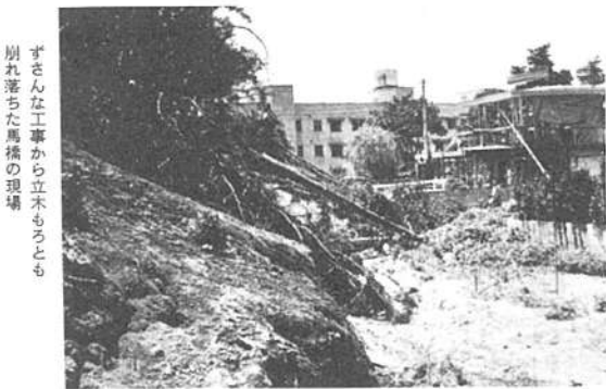
ずさんな工事から立木もろとも、崩れ落ちた馬橋の現場
