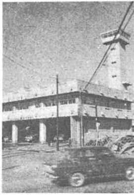
六月二十三日、松戸新田内に建設を急いでいた「消防合同庁舎」が総工費六千八百万円で作成、西口分署に仮住まいしていた消防本部、中央署が移転し、西口分署が正式に新築した。(右)
