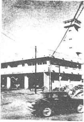
六月二十三日、松戸新田地区に建設を急いでいた「消防合同新庁舎」が総工費六千八百万円で作成。西口分署に仮住まいしていた消防本部・中央署が移転し、西口分署が正式に新築した。(右)
