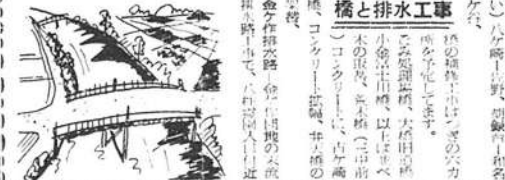
橋と排水工事
