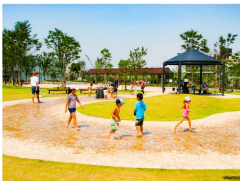
防災公園の施工
