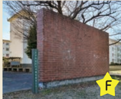
昔からあるレンガ壁
