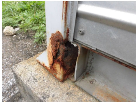
錆びによる腐食がある
