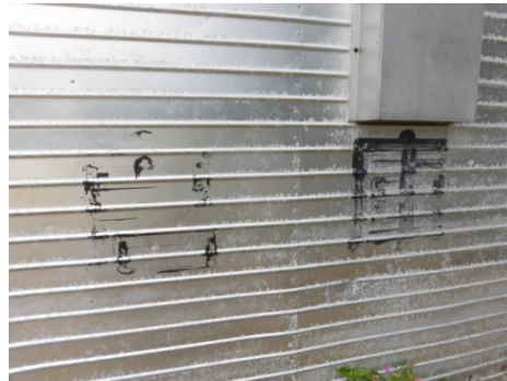
錆びによる腐食がある
