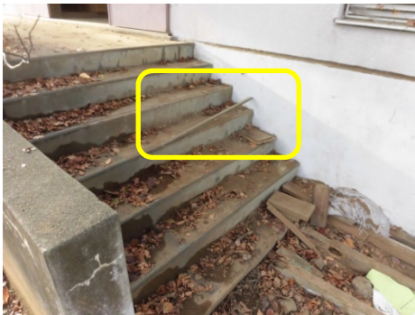
階段に破損箇所あり（上本郷防災倉庫）
