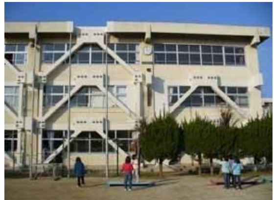
耐震改修済の学校
