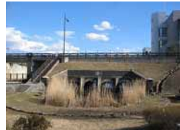
柳原水閘(土木学会選奨土木遺産)
