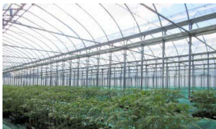
【パイプハウス】
