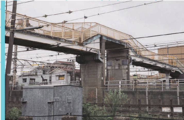
【JR二段式歩道橋】馬橋駅と新松戸駅の中間にある中央が一段盛り上がっている。貨物線が通る敷地だけが高くなっているため、この構造になったと思われる。
