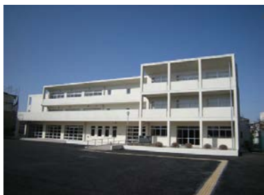
小金中学校改築工事
