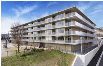
東松戸小学校新築工事
