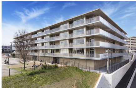
東松戸小学校新築工事
