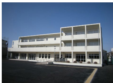
小金中学校改築工事
