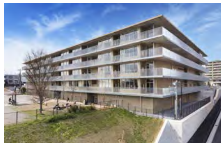
東松戸小学校新築工事
