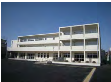
小金中学校改築工事
