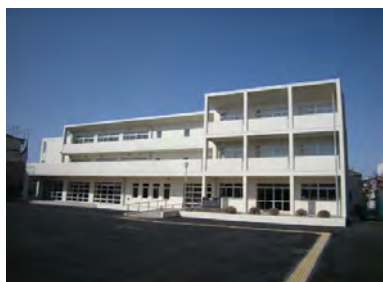
小金中学校改築工事
