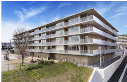
東松戸小学校新築工事
