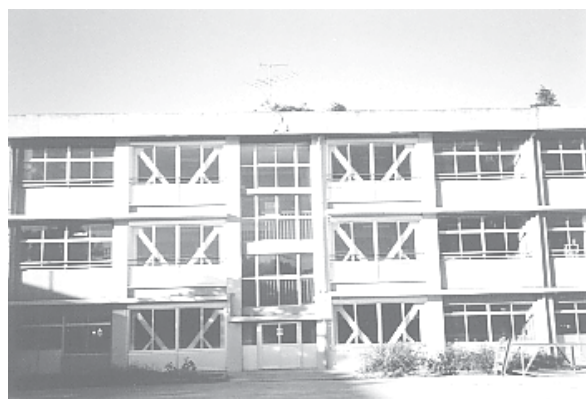
校舎耐震改修工事
