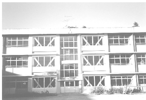
校舎耐震改修工事
