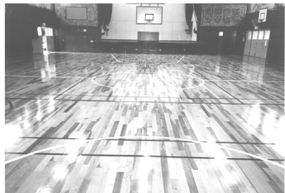
屋内体育館改修工事
