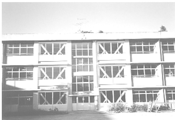
校舎耐震改修工事
