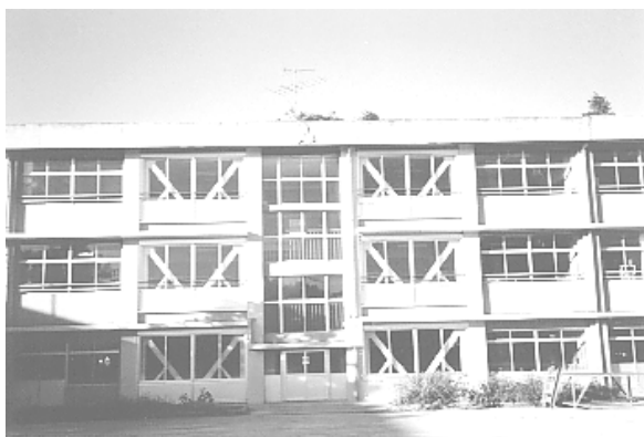
校舎耐震改修工事
