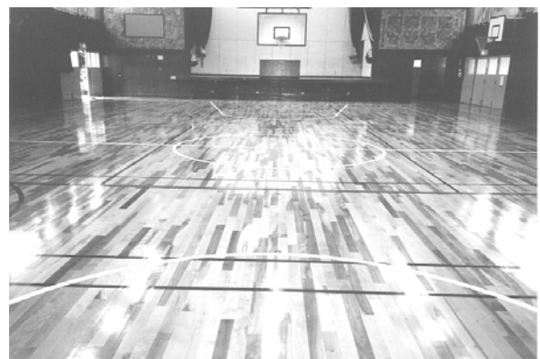
屋内体育館改修工事
