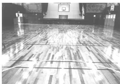
屋内体育館改修工事
