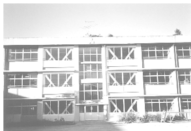
校舎耐震改修工事
