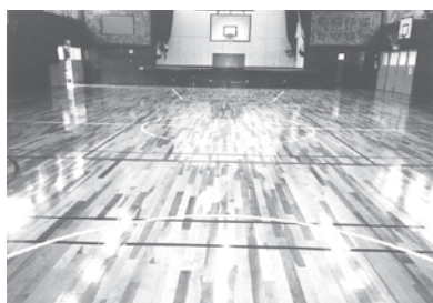
屋内体育館改修工事
