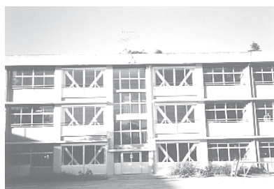
校舎耐震改修工事
