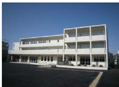
小金中学校改築工事
