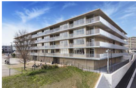
東松戸小学校新築工事
