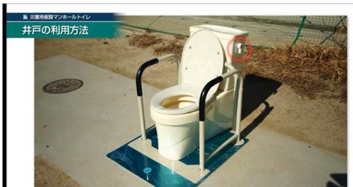
使用時は洋式トイレと同様にタンク横のレバーで水を流す
