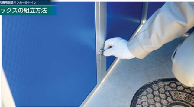
本体内部下の左右のフックで固定
