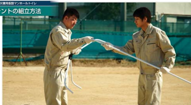
曲げパイプに柱パイプを差し込む
