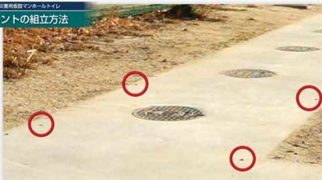
マンホールの四隅にあるネジを確認
