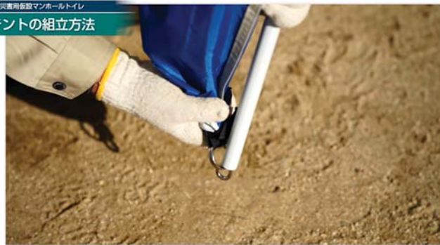
下側四隅にある金具をパイプに差し込む
