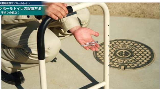
手すりパイプと後ろパイプを固定する
