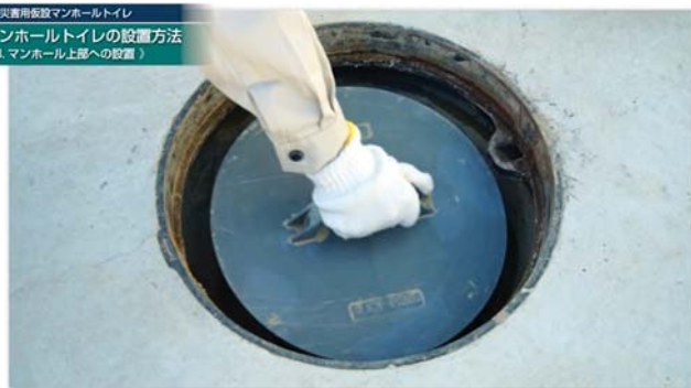
マンホールの蓋と内蓋を外す
