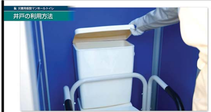
トイレタンクの蓋を外し 水を入れる
