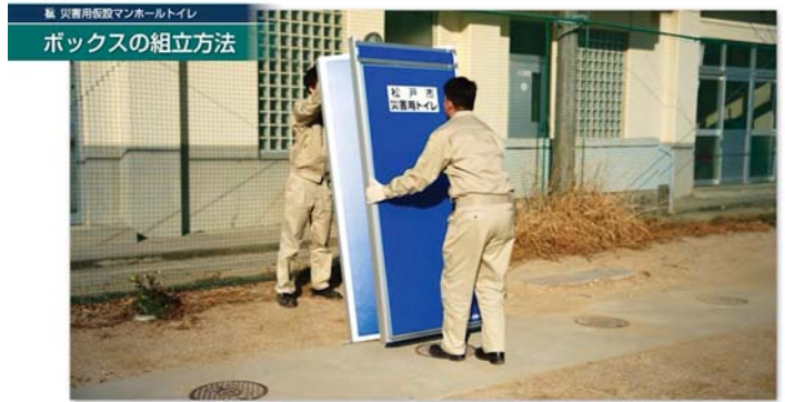
マンホール上部に立てて伸ばす
