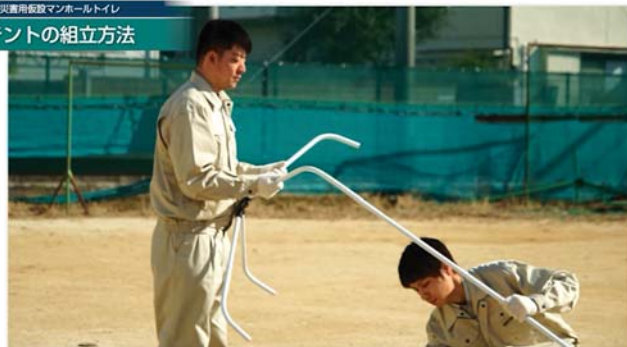
曲げパイプに柱パイプを差し込む
