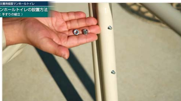
ボルトをナットで固定する
