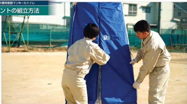
テント生地を開いてかぶせる
