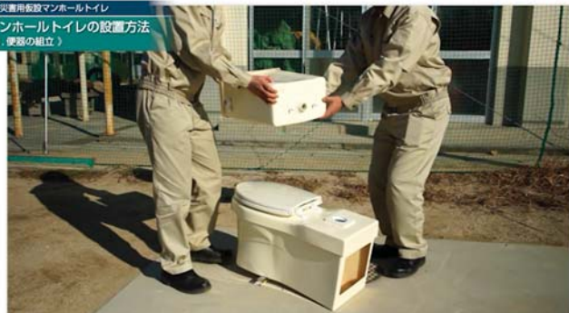
タンクを便器に固定する
