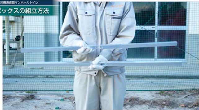
Cチャンネル(C型の金具)を差し込んでまっすぐな状態を保つ
