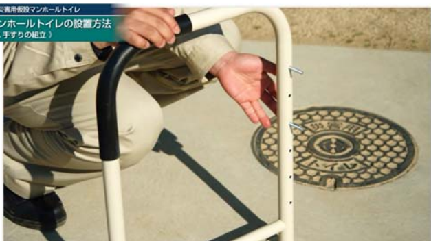
左右のボルト差し込み位置を揃える
