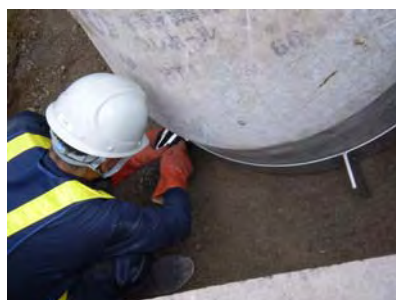
固定バンドの取付け
