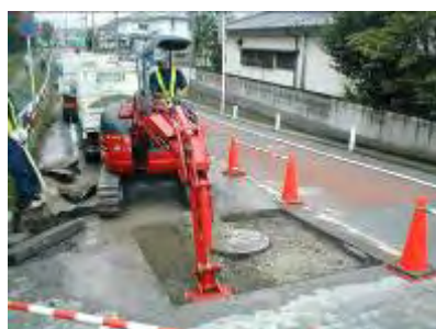
小さな作業スペース
