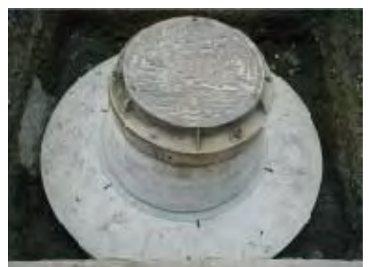
浮上抑制ブロック設置完了
