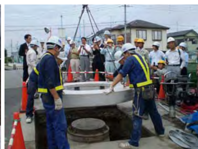
浮上抑制ブロック設置
