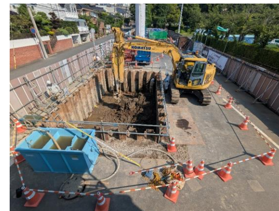
TNo.2-3 立坑掘削状況 (立坑掘削)
