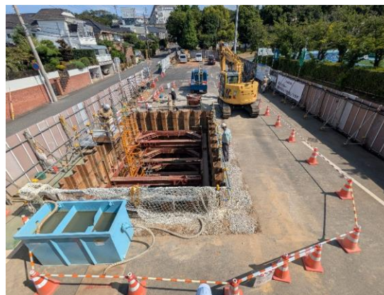
TNo.2-3 掘削完了 (立坑掘削)
