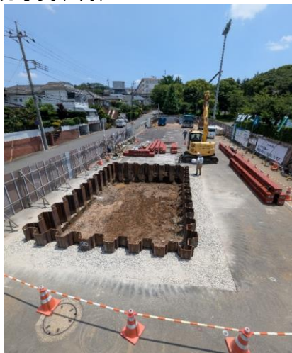
TNo.2-3 掘削前 (立坑掘削)
