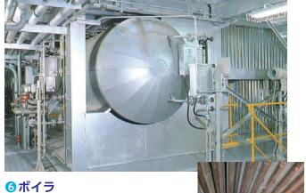
高温の燃焼ガスから熱を回収し蒸気を発生させる 設備です。これにより排ガスは冷却されます。
