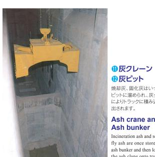
焼却灰、固化灰はいったん灰 ピットに溜められ、灰クレーン こよりトラックに積み込まれ搬 出されます。
