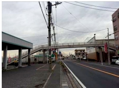
古ヶ崎歩道橋
