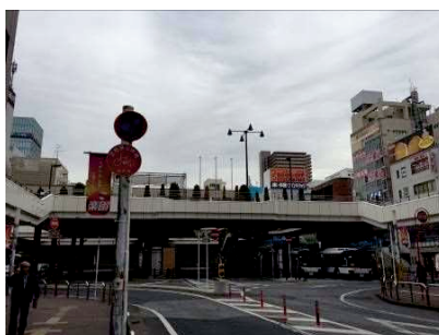
松戸駅西口デッキ
